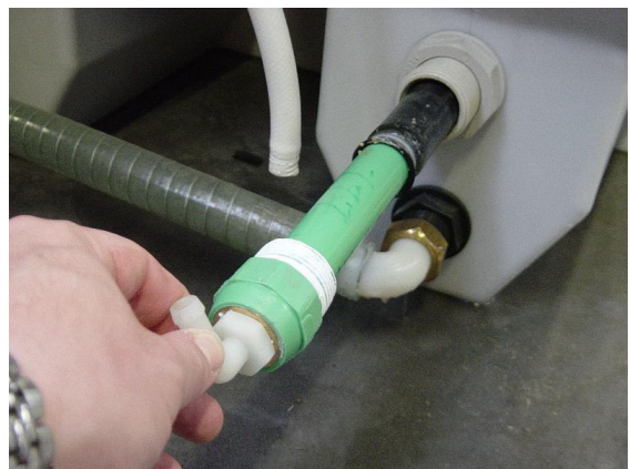
Retrait de l'unité de ventilation
