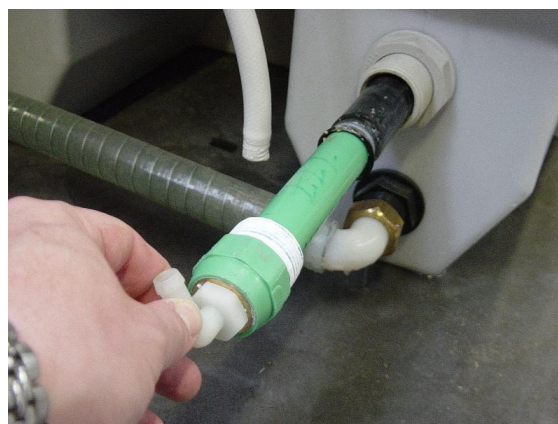
Desmontaje de la unidad de ventilación
