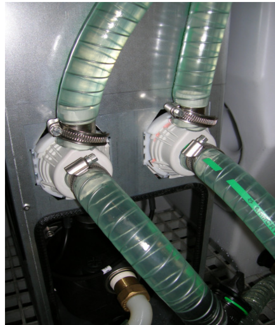
tubi di aspirazione + tubi di mandata
