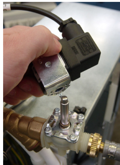
Retirada de la bobina
