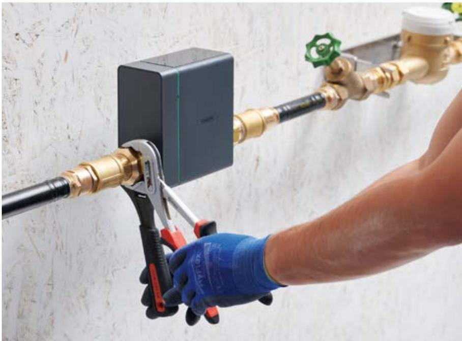
Die Montage erfolgt an der Hauptwasserleitung nahe am Wasserzähler. Mehr Details zur Installation finden Sie auf der hansgrohe PROServices Website:
