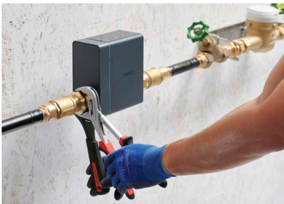
**Die Montage** erfolgt an der Hauptwasserleitung nahe am Wasserzähler. Mehr Details zur Installation finden Sie auf der hangrohe PROServices Website: [pro.hangrohe.de](http://pro.hangrohe.de)
