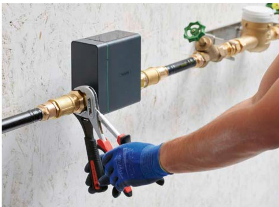
Pontos Base se monta en la tubería principal, cerca del contador de agua. Encontrarás más detalles sobre la instalación en la página web de hansgrohe PROServices:
