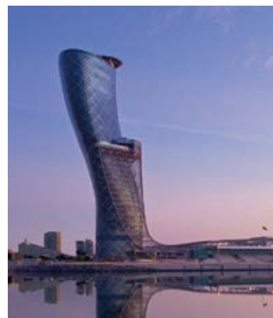
Hyatt Capital Gate Hotel, Abu Dhabi : douche de tête Raindance® S 240.
