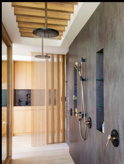
Alargó de la conexión al techo, adaptada a la altura de la estancia
