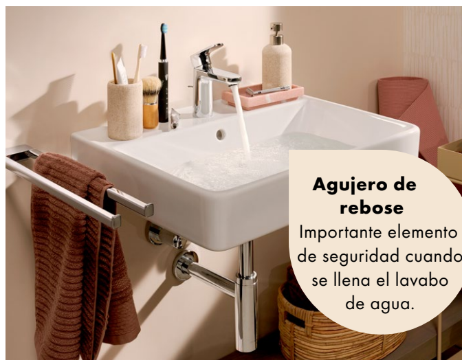
Lavabo fijado a la pared
