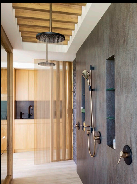
Forlængelse af en loftstilslutning – tilpasset til rummets højde
