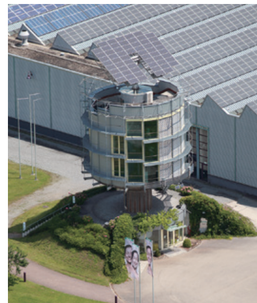
1995年開設、ソーラータワー
