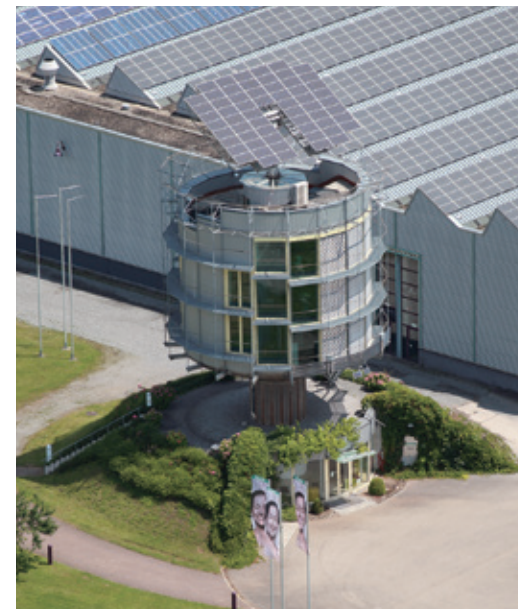
1995年開設、ソーラータワー
