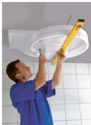
1. Grundkroppen af styropor tilrettes og borehullerne optegnes.
