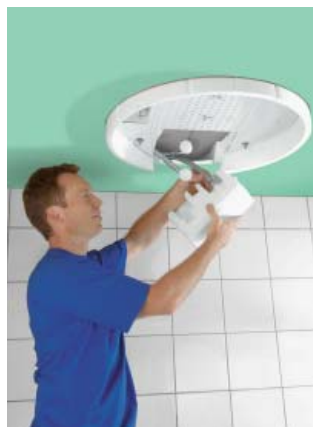
7. Bræk det overskydende af styroporblokken for at komme til tilgangsrørerne.
