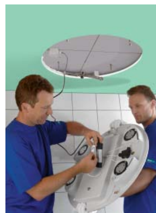
14. Sikringsbåndet monteres. Belysningen forbindes med transformatoren. Sluttelig funktionsprøves.
